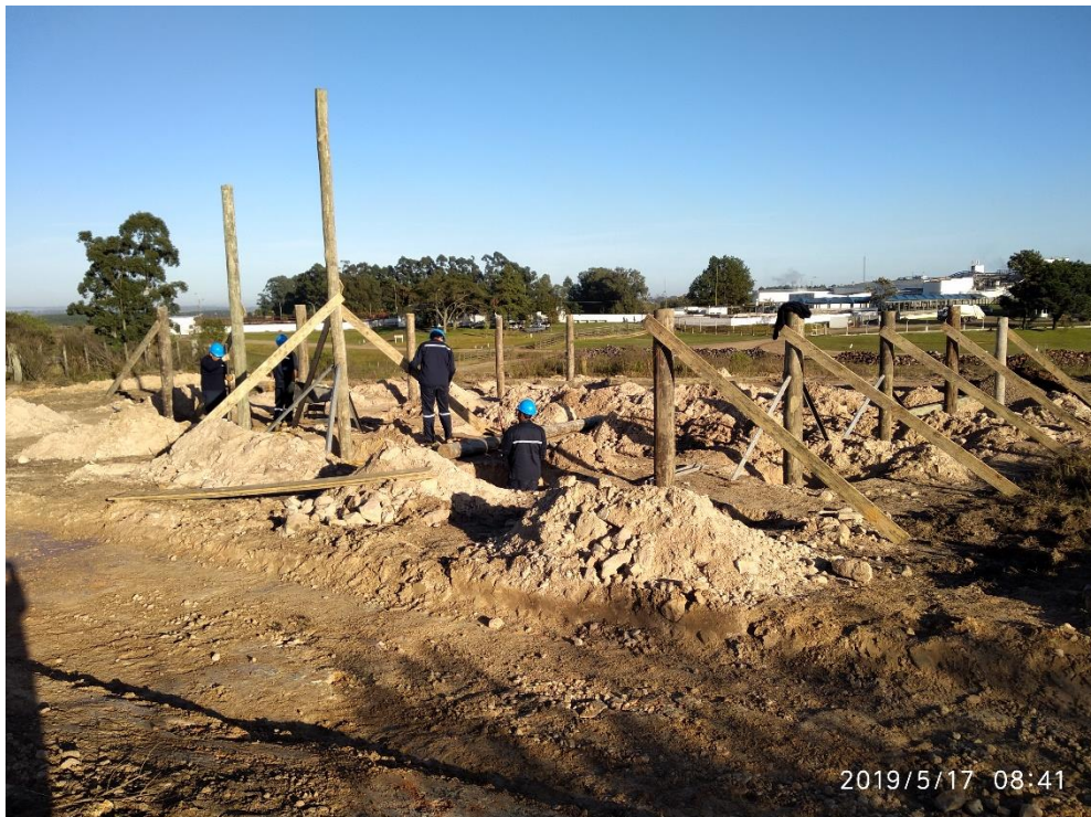
Imagen 4. Construcción de estructura.
