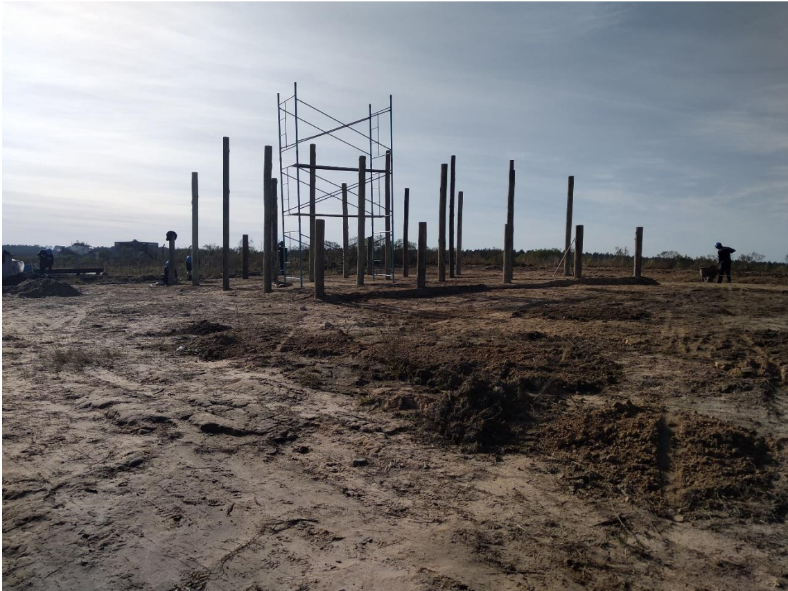
Imagen 5. Construcción de estructura.
